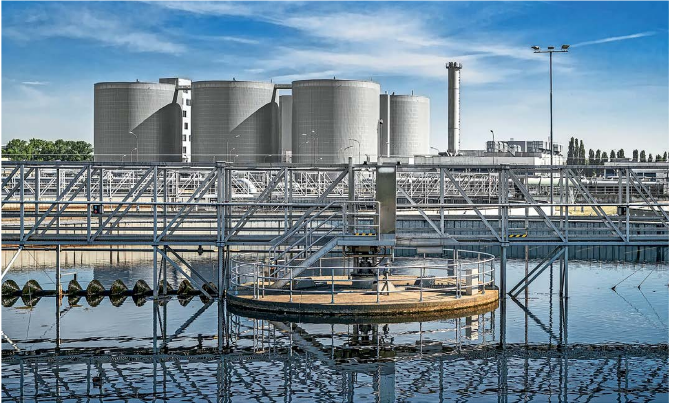
Die 30 Meter hohen Faulbehälter der EBS Wien Hauptkläranlage produzieren 20 Millionen Kubikmeter Klärgas pro Jahr.
