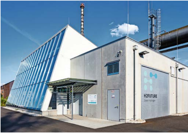
Die Produktionsanlage für grünen Wasserstoff vom Projekt H2Future am Gelände der voestalpine, die künftig „grünen Stahl“ erzeugen will.
