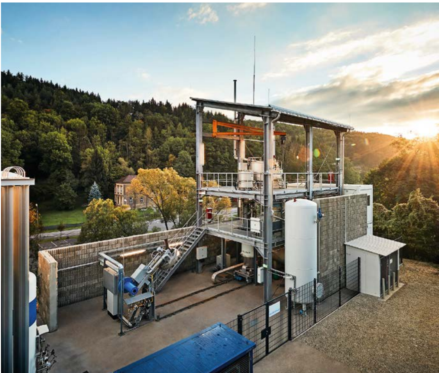
Die Pilotanlage des Projekts SuSteel am voestalpine-Standort Donawitz ist ein wichtiger Schritt für eine klimafreundliche Stahlproduktion.
